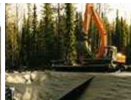
Class 1a Hazardous Waste Landfill
